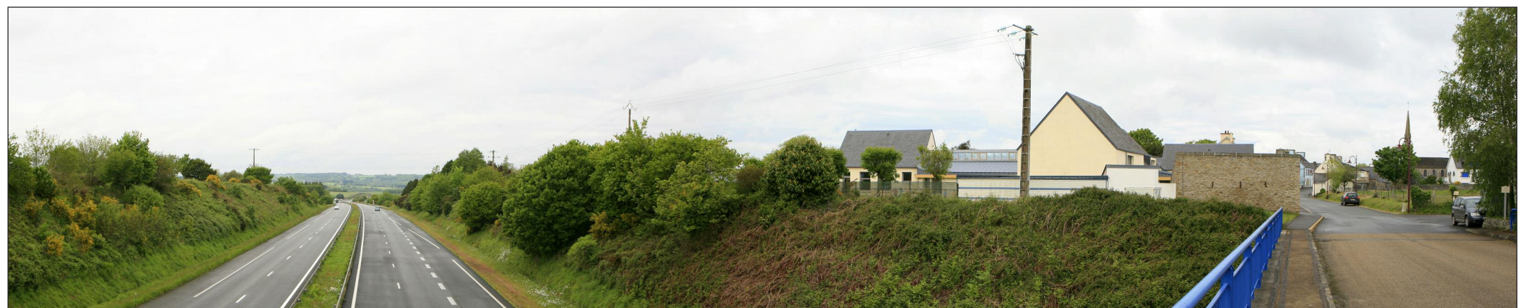
Vue du site avant projet
