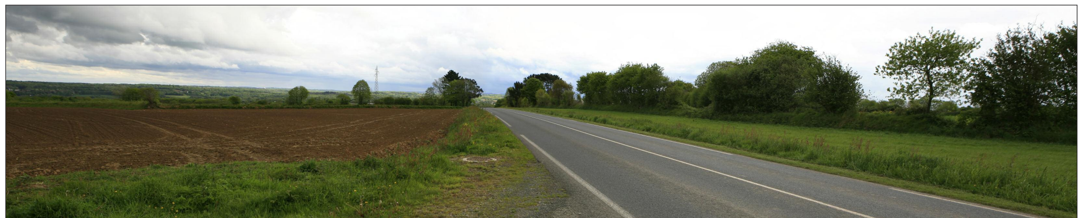
Vue du site avant projet
