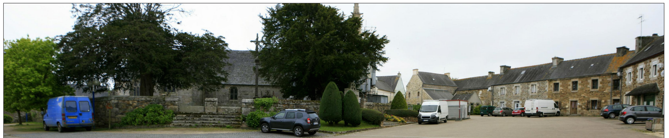
Vue du site avant projet
