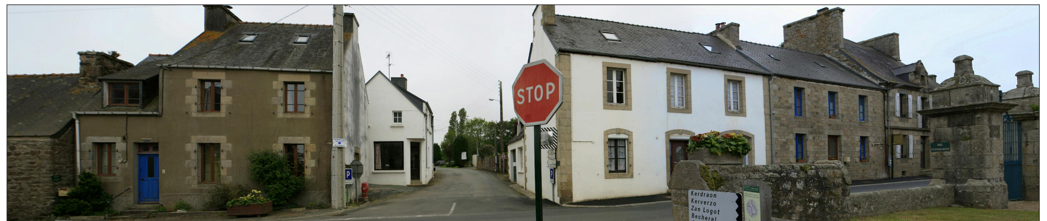
Vue du site avant projet
