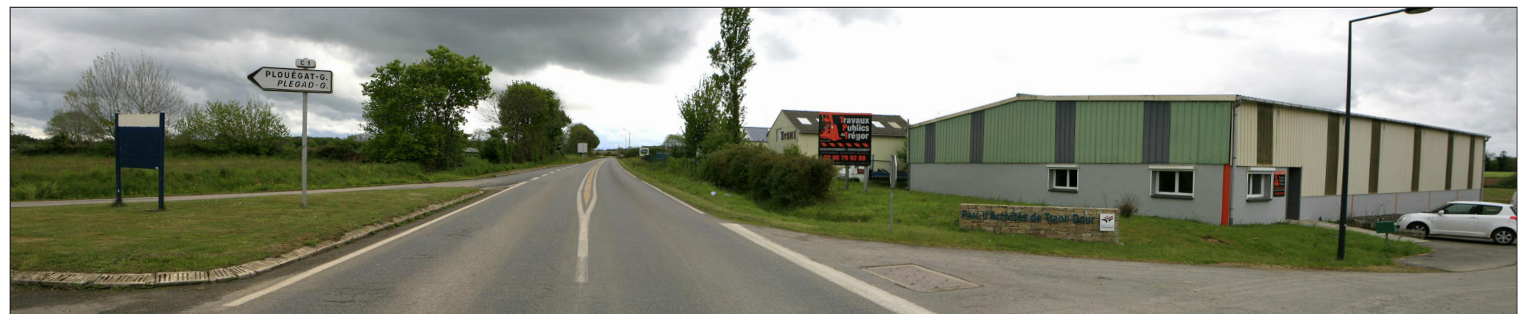
Vue du site avant projet
