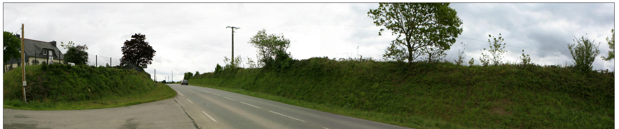
Vue du site avant projet
