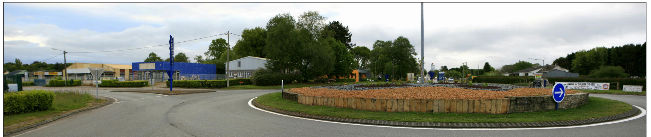
Vue du site avant projet
