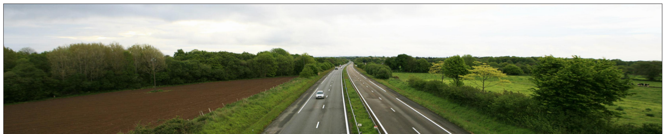
Vue du site avant projet
