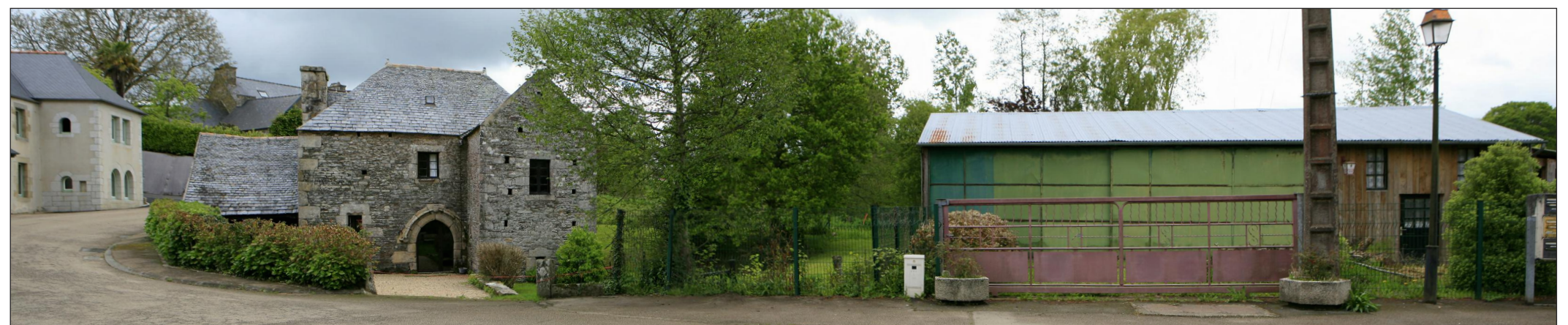
Vue du site avant projet
